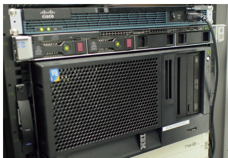
札幌ドーム施設内のuniConnectシステム
